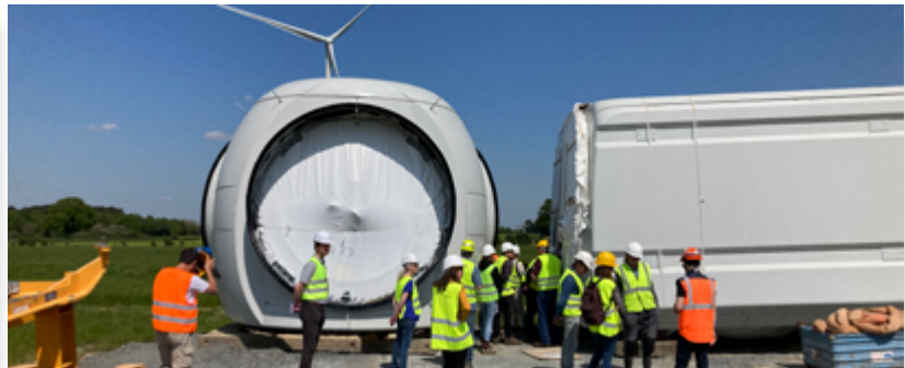
Visite du chantier du parc de Derval, avril
