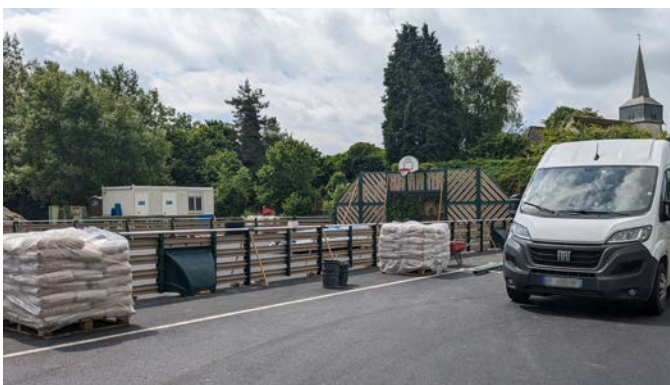
Le City Stade en construction
